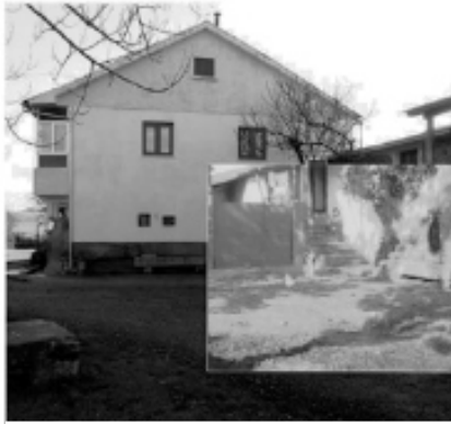
Figura 1 - Nova construção sobre o pátio da Quinta de Campelo
